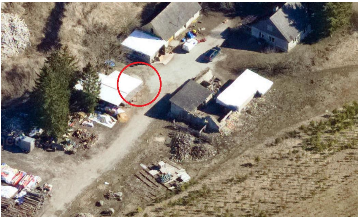
Foto 4. Ilma betoonrajatiseta Mäeotsa tee 2 kinnistu (Väljavõtte Maa-ameti fotolao 05.04.2020 fotost).
