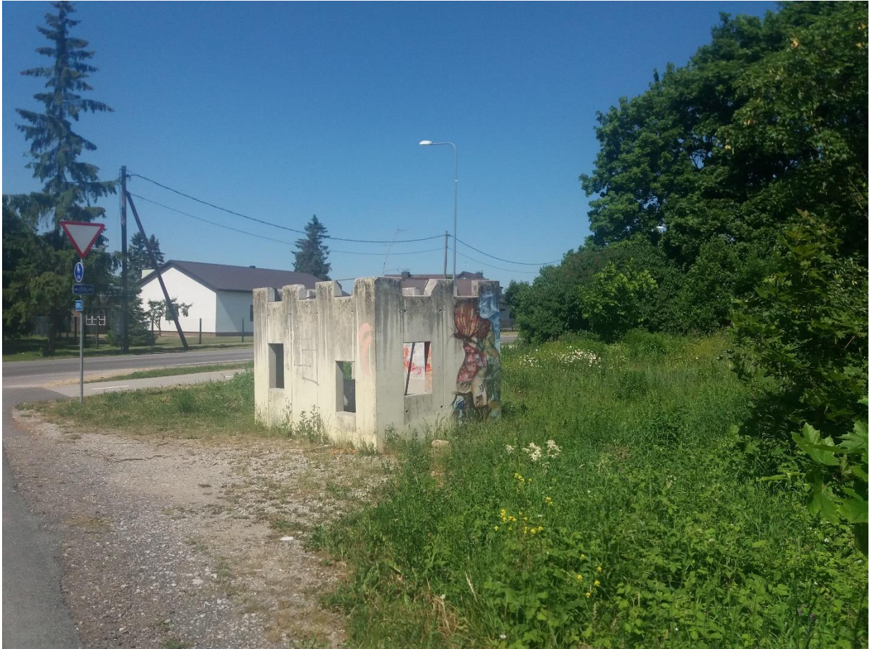
Foto 5. Betoonrajatis Viinamäe tee 2 kinnistul (Fotografeeritud 25.06.2020).
