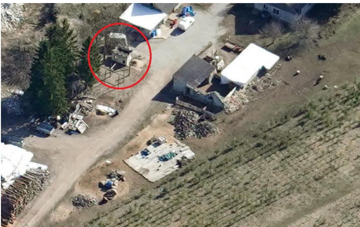
Foto 2. Betoonrajatis Loo alevikus Mäeotsa tee 2 kinnistul (Väljavõte Maa-ameti fotolao 18.04.2019 fotost).
